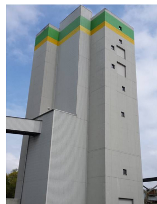
Bloc de silo
