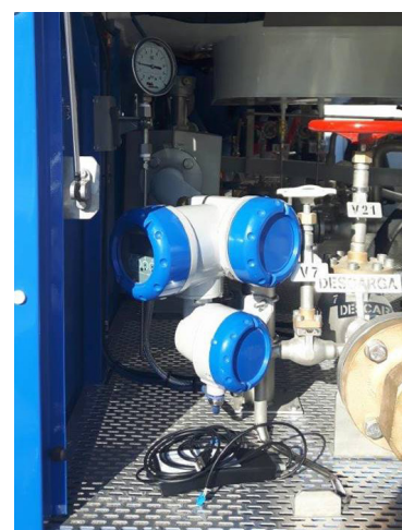
Convertisseur de mesure du débitmètre massique Coriolis OPTIMASS 6400 monté sur le distributeur de GNL
