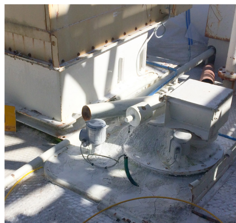
Mesure de niveau de talc en poudre
