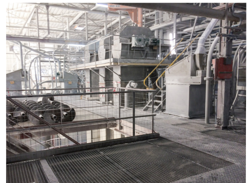
Silos de talc en poudre
