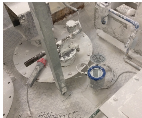
Transmetteur de niveau OPTIWAVE 6500 en haut d'un silo de stockage
