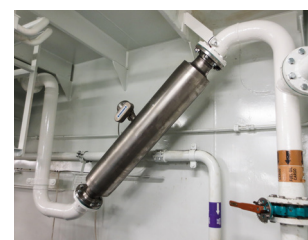
Прибор OPTIMASS 2400 F для установки в бункерах
