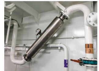
OPTIMASS 2400 F Messgerät für die Bunkerung
