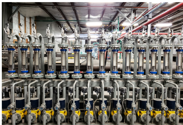
Měření průtoku vodíku plováчковým průtokoměrem VA 40
