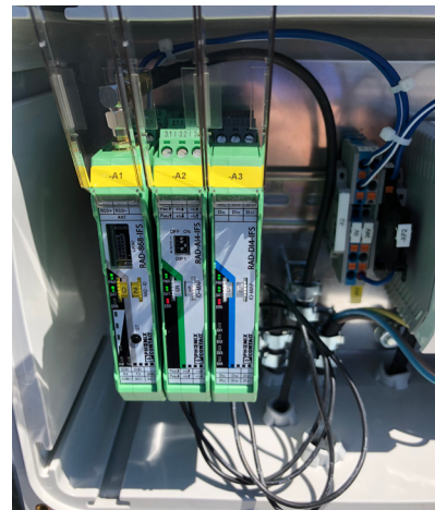
Беспроводные модули и модули входа/выхода для передающего блока KRL70 на скребке
