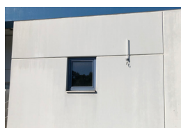
Антенна приемного блока, устанавливаемая на здании
