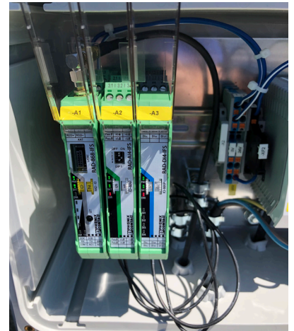
Módulos inalámbricos y de E/S para la unidad emisora KRL 70 en el rascador
