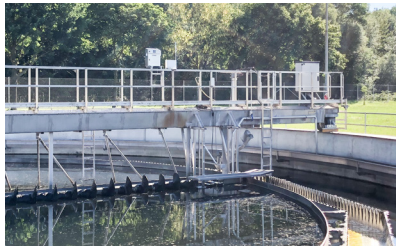
OPTISYS SLM 2100 y KRL 70 en el puente rascador
