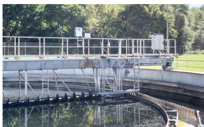
OPTISYS SLM 2100 a KRL 70 na mostu vyhrabávače
