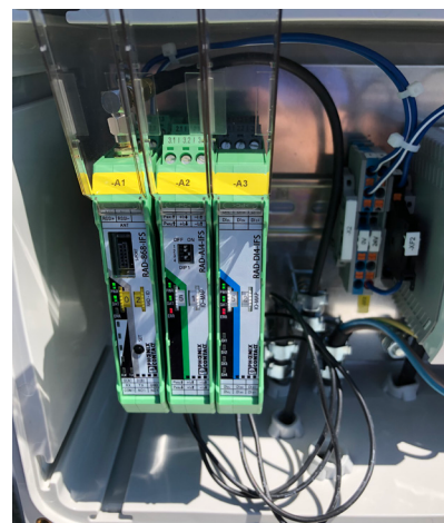
Rádiové moduly a moduly vstupů/výstupů pro modul vysílače KRL 70 na vyhrabávači
