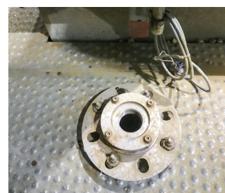
Schwenkbarer Flansch zur Antennenausrichtung
