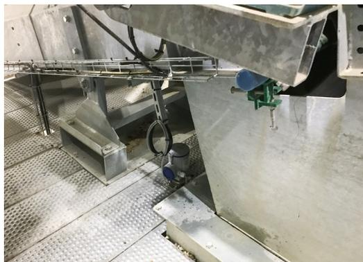
Transmetteur de niveau radar OPTIWAVE 6500 sur silo de granulats
