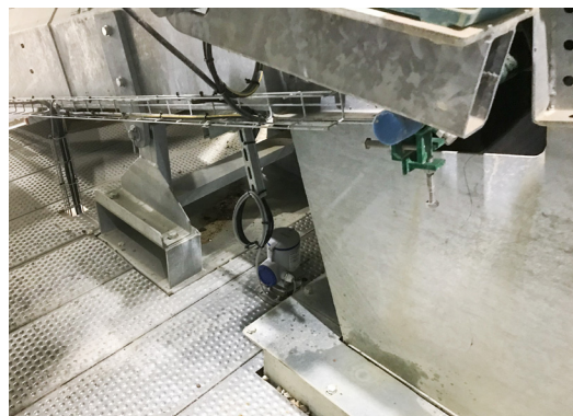
Радарный уровнемер OPTIWAVE 6500 на силосе для инертных материалов
