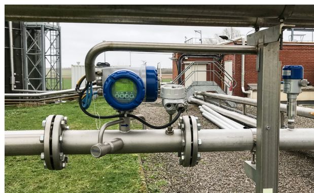
Débitmètre à ultrasons OPTISONIC 7300 Biogaz en sortie de méthaniseur et transmetteur de pression OPTIBAR PM 5060
