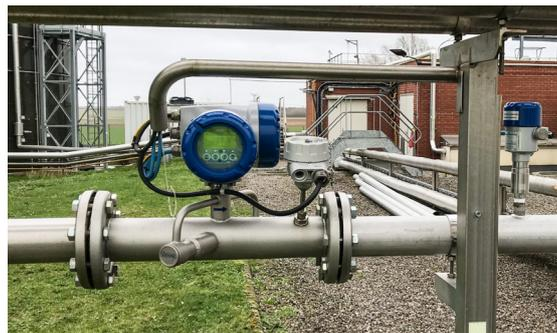
Ultraschall-Durchflussmessgerät OPTISONIC 7300 Biogas und Druckmessumformer OPTIBAR PM 5060 am Ausgang des Faulturms installiert
