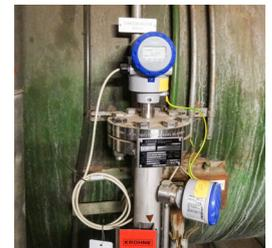
Messumformer des TDR-Radars (oben) und Elektronik des LT40
