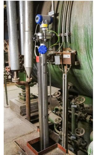
Bypass-Messung mit BM 26 A und OPTIFLEX 2200
