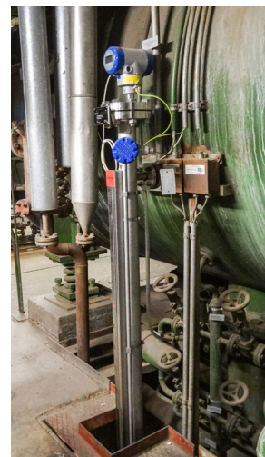
Měření v obtoku s hladinoměry BM 26 A a OPTIFLEX 2200
