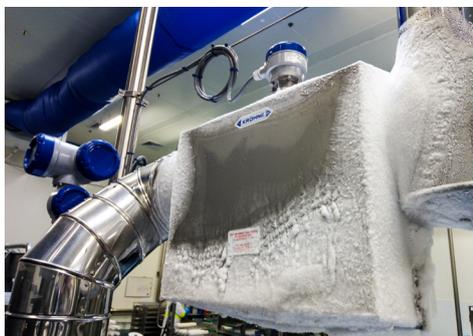
Masse-Durchflussmessung von flüssigem Stickstoff für Gefriertunnel mit dem OPTIMASS 6400 F
