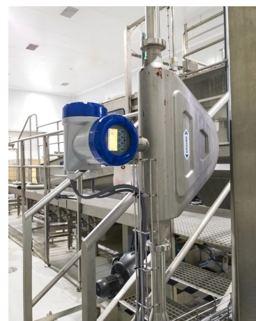
Измерение расхода томатной пасты с помощью OPTIMASS 6400 C
