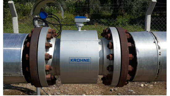
Jeotermal brine'in ultrasonik akış ölçümü
