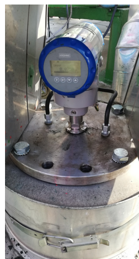
OPTIFLEX 7200 namontovaný na hrdle nádrže
