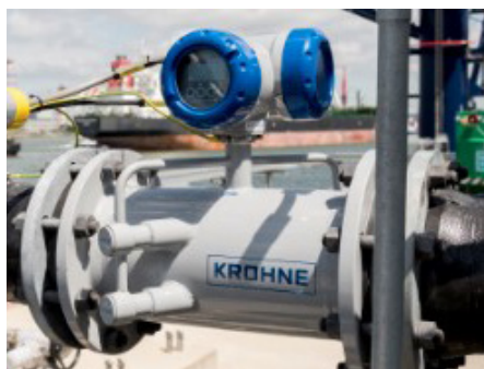
Ультразвуковой метод измерения расхода паров углеводородов
