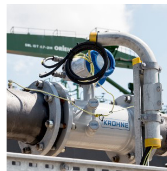
Конструкция с полнопроходным сечением ультразвукового расходомера OPTISONIC 7300
