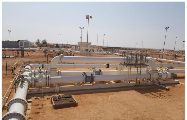
Messskids mit dem OPTILUX 2300
