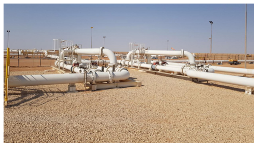
Оба водомерных узла установлены рядом
