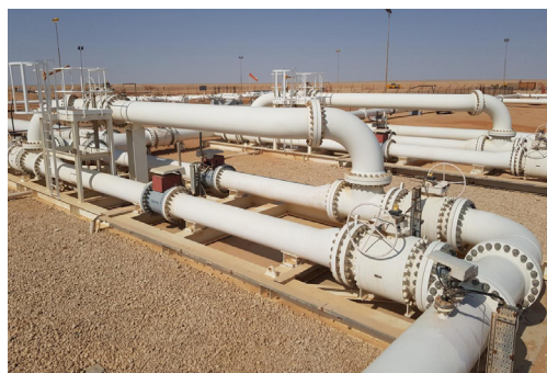
Система учета на входе водоочистной станции
