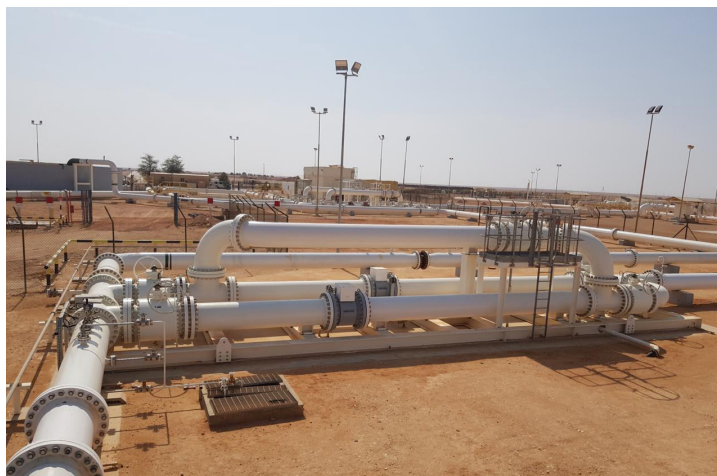
Водомерные узлы с OPTIFLUX 2300
