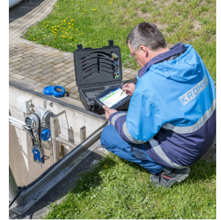
Durchführung einer Geräteverifikation auf der Kläranlage
