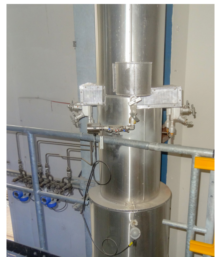
Kalibrierte Messstrecke mit Venturidüse, OPTIBAR DP 7060, OPTIBAR PM 3050 und OPTITEMP TRA-S34
