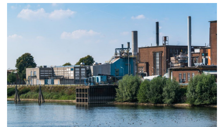
Altes Kesselhaus mit neuem Biomasse-Kessel im Industriepark Kleefse Ward (IPKW)
