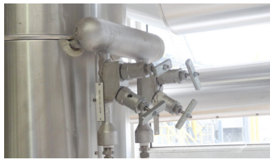
Installation der Venturidüse
