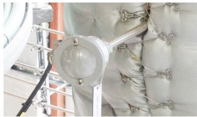
Temperaturmessung mit dem OPTITEMP TRA-S34
