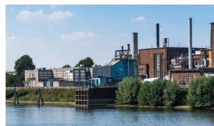
Stará kotelna s novým kotlem na biomasu v průmyslovém parku Kleefse Waard (IPKW)
