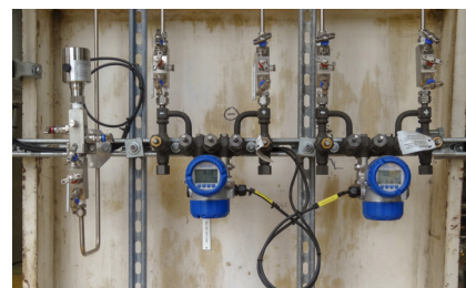
OPTIBAR DP 7060 (uprostřed) a snímač relativního tlaku OPTIBAR PM 3050 (vlevo)
