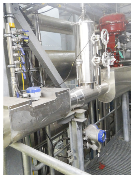
Měření napájecí vody pomocí ultrazvukového průtokoměru OPTISONIC 3400
