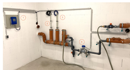
1 MAC 100 2 OPTISENS PH 8300 mit SENSOFIT IMM 1000 3 OPTISENS IND 1000 mit Eintaucharmatur 4 Messwertaufnehmer des OPTIFLUX 4300 F
