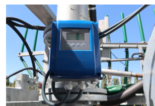
Caudalímetro KROHNE instalado en un esparcidor de purines
