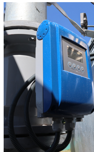
Medida de caudal de purines con el OPTIFLUX 2100
