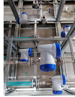
Köpük üretimi için katkı maddelerinin akış ölçümü
