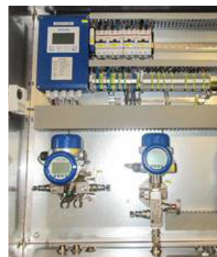
Rozvaděč se snímači tlaku a tlakové difference, snímačem teploty a přepočítavačem průtoku KROHNE
