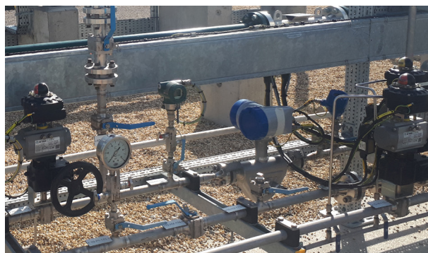
Mesure de débit d'hydrogène et de méthane de synthèse (SNG) avec l'OPTIMASS 6400
