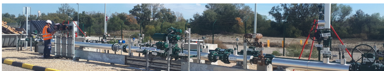
OPTISONIC 7300 C : Mesure par ultrasons du débit de gaz naturel issu du réseau
