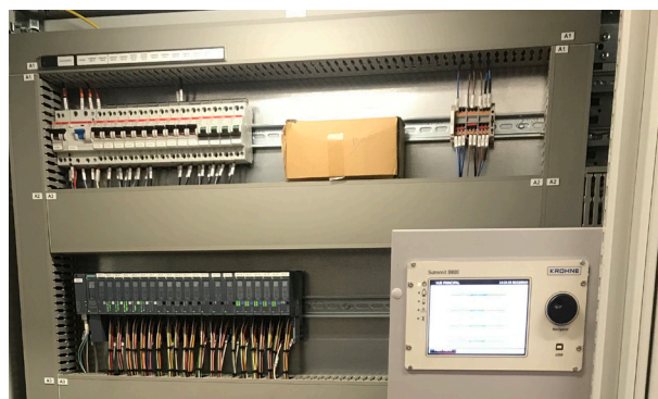
Calculateur de débit SUMMIT 8800 dans l'armoire électrique
