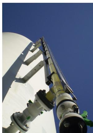
Indicateur de niveau magnétique conçu sur mesure pour une hauteur de réservoir de 12 m
