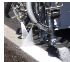
Automatizované značení silnic nákladním vozem
