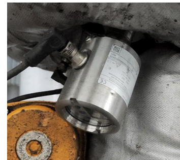
Hydrostatische Fullstandmessung von Speiseol mit dem OPTIBAR PM 3050
