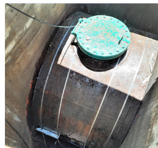
OPTISONIC 6300 montiert auf Rohrleitung aus Kohlenstoffstahl in Nennweite DN2300
