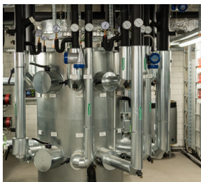
System zur Betonkerntemperierung
