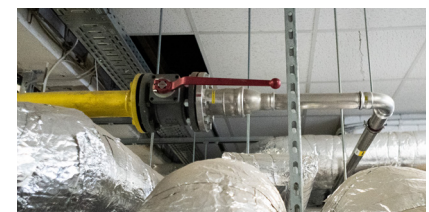
Erdgasleitung mit erneuerter, verjüngter Rohrführung rechts
