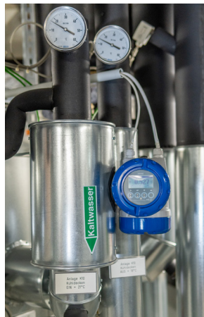
Kälte- und Wärmemessung mit dem WATERFLUX 3300
