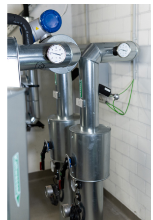
WATERFLUX 3300 misst den Rücklauf zu den Erdsonden
