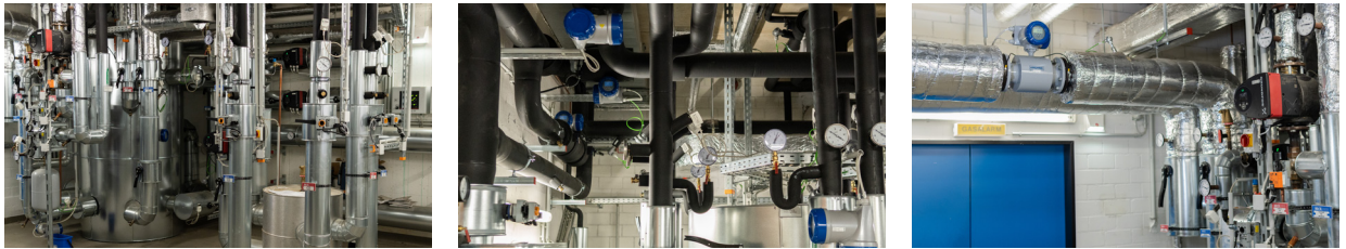
Durchflussmessung von Wärme und Kälte mit magnetisch-induktiven Durchflussmessgeräten von KROHNE
