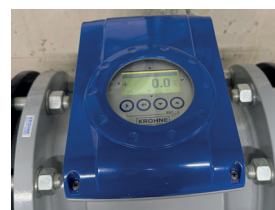
Durchflussmessung von Wäschereiabwasser mit dem OPTIFLUX 2050
