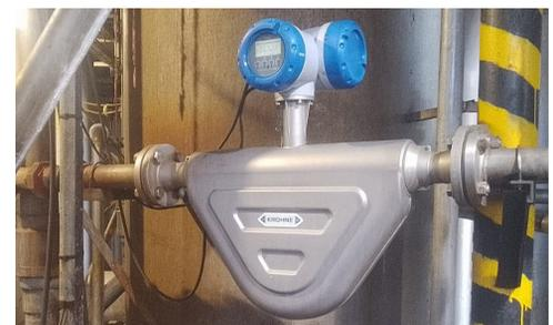
Inline-Konzentrationsmessung von Abwasser aus der Fischverarbeitung mit dem OPTIMASS 6400
