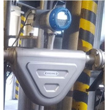
Durchfluss- und Dichtemessung zur Steuerung der Prozesswasserverdampfung
