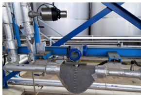
Messsystem nach MI-005 für Essig mit dem OPTIMASS 6400
