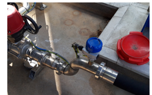
OPTISWITCH 5100 für den Trockenlaufschutz der Pumpen
