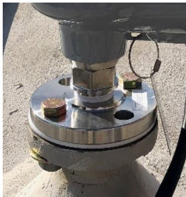
Installation von Füllstandmessgerät mit PTFE-Dichtung zwischen Flansch und Linsenantenne
