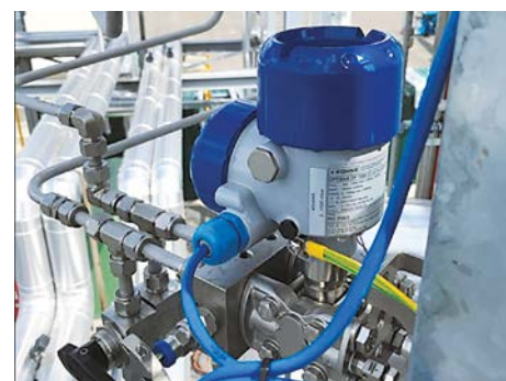
700 bar hogedruk uitvoering van de KROHNE OPTIBAR DP 7060 transmitter, voor veeleisende flowmeting van waterstof.
